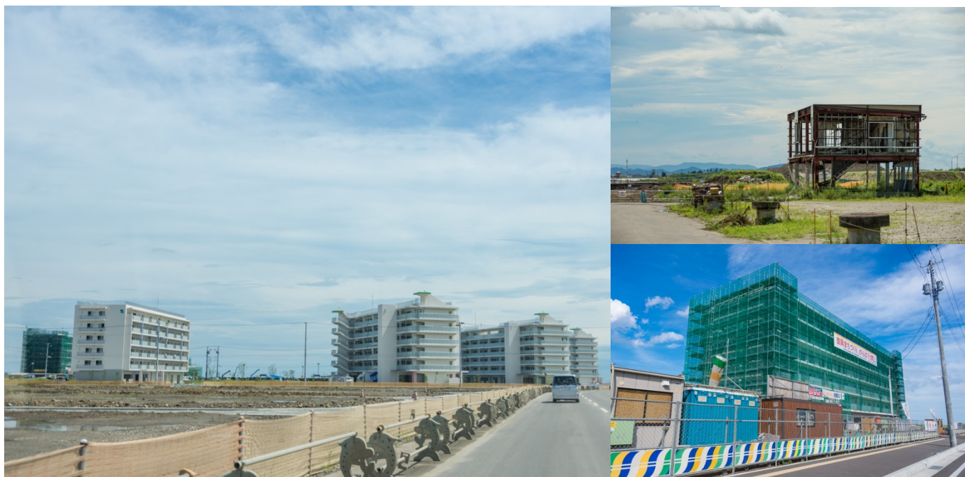
写真 5,6,7 工事の進む閑上地区の様子
